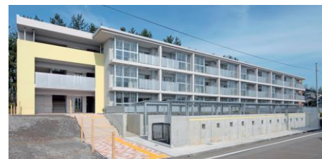
鶴ヶ丘団地公営住宅（石川県内灘町）
