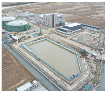
統合浄水場の建設（新潟県燕市）
