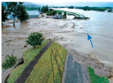
堤防決壊状況(令和元年10月13日)
