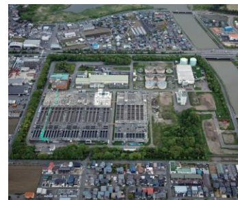
下水処理場（新潟県新潟市）
