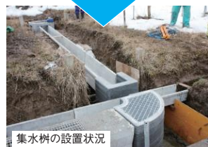
複雑な形状の構造物を3Dプリンタで製作・設置(工期短縮・省力化)
