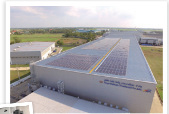
上) 上空からの写真 左) 太陽光パネルとインバーターの設置状況
